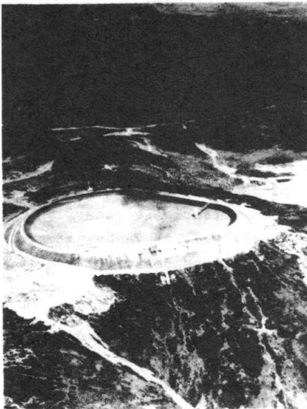
Figur 3.3 Billedet viser det kunstige øvre reservoir ved Turlough Hill i Nordirland. Reservoiret rummer 2,6 \times 10^6 \text{ m}^3 vand og højdeforskellen mellem øvre og nedre reservoir er i middel 286 m. Det nedre reservoir består af søen Lough Nohanagan. (McMullan, 1976).
